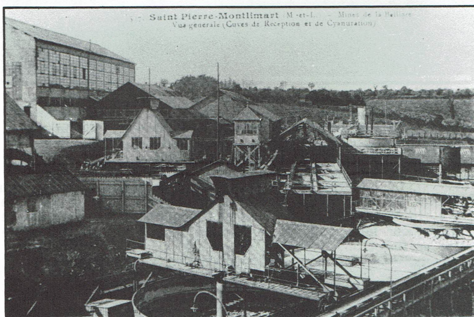
Cuves de réception et de cyanuration.
