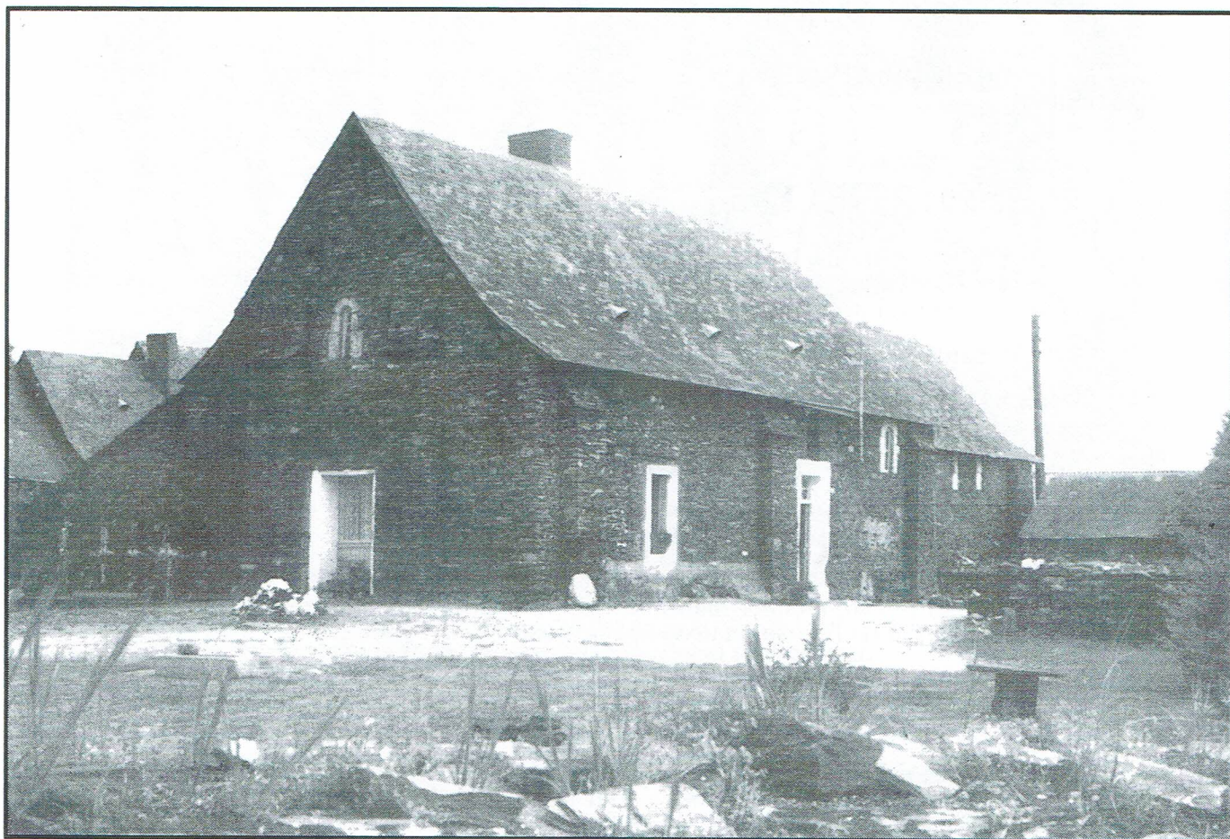
L'ancienne église (XII ème - XIII ème siècle), façades ouest et sud (Cliché de l'auteur, septembre 1991)
