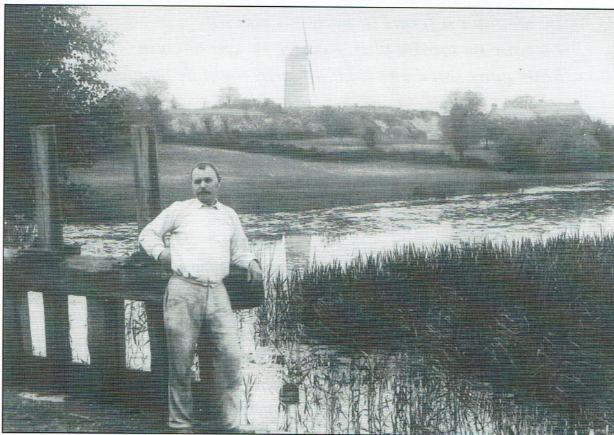
Depuis le Moulin Pelé on aperçoit à l'horizon le Moulin de Cossarde
