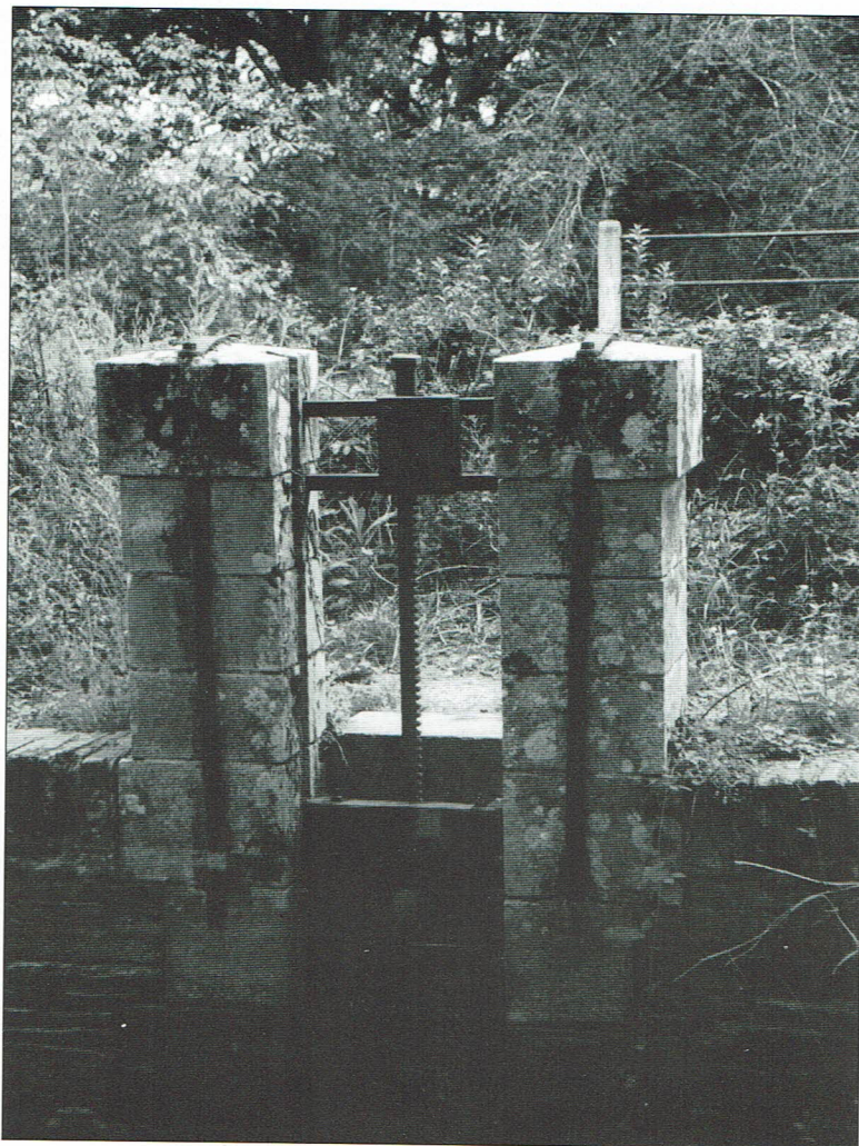
Petite écluse sur le canal des Ajaux
