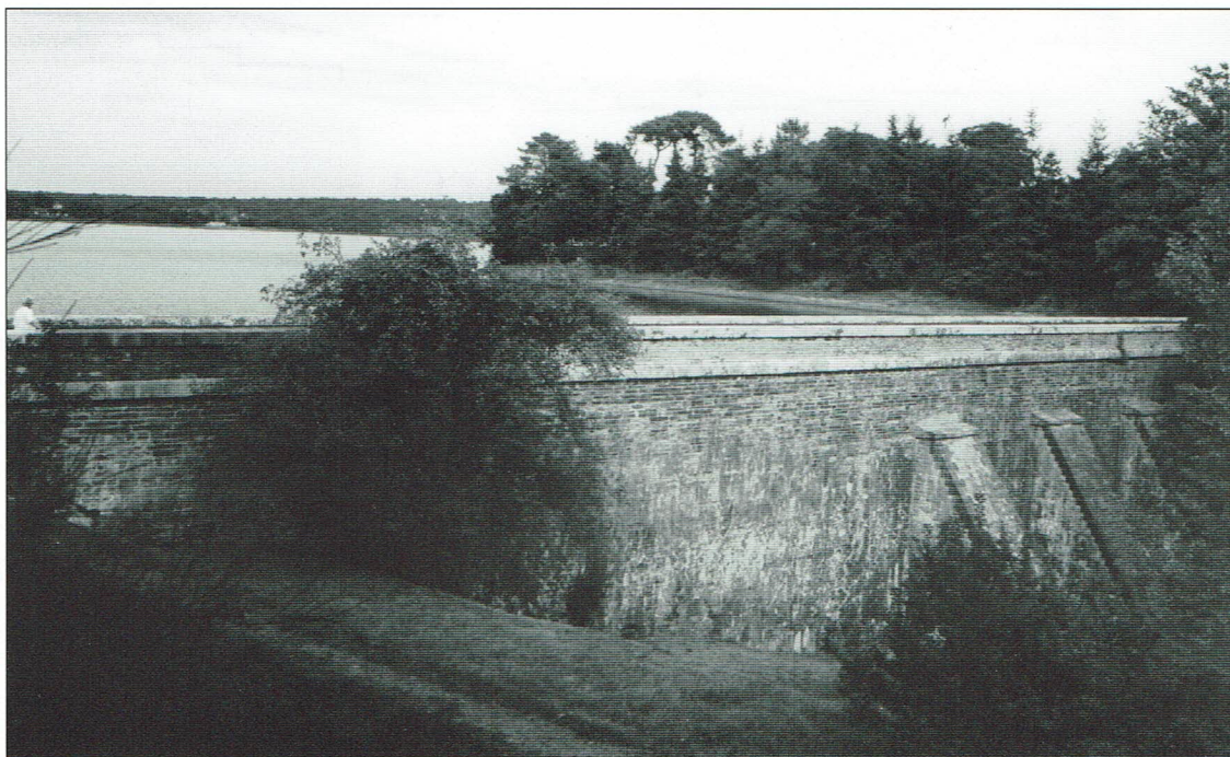
Le Barrage avec contreforts et parapet
