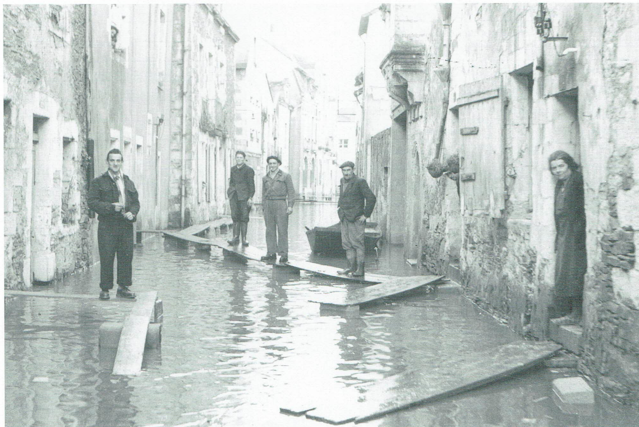
Rue du Château à Ancenis lors de la crue de décembre 1952 (maximum de la crue, le 25 décembre, + 6,37 m à l'échelle d'Ancenis). De petits ponts de planches permettent de passer d'un seuil de porte à l'autre. Une plate de Loire est le seul moyen de transport dans les rues inondées de la ville. Ph. Studio Garreau, Ancenis.
