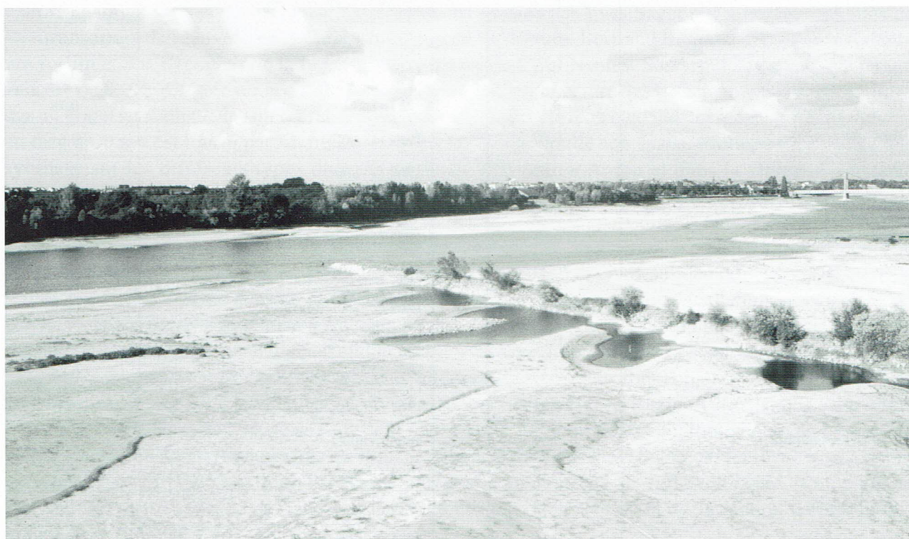
La Loire en période d'étiage à Ancenis. Grèves de sable bordant, le long de l'île Verte, la rive sud du chenal de navigation. Remarquer l'épi transversal (barrage) bordé de "trous" du côté de l'aval. Ph. L. Ménanteau, 20-08-1996.
