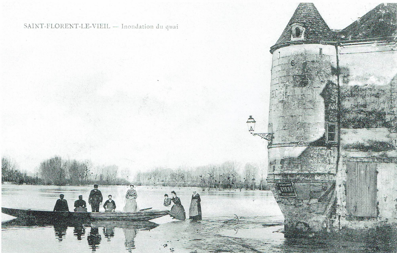
Inondation du quai devant la tourelle de la Gabelle (Saint-Florent-le-Vieil) lors de la crue de décembre 1910. Coll. Christian Cezilly, Sanlúcar la Mayor, Espagne.
