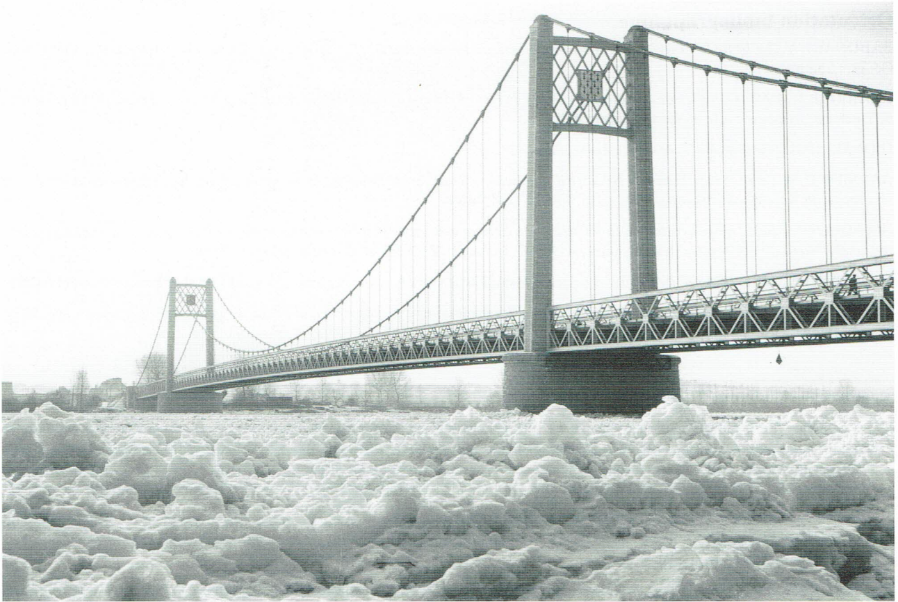
Embâcle de la Loire à Ancenis en février 1956, vu depuis le quai de la Marine en amont du pont (inauguré en 1954). A remarquer l'amoncellement et le chevauchement des glaçons donnant un aspect "moutonné" au fleuve. Ph. Studio Garreau, Ancenis.
