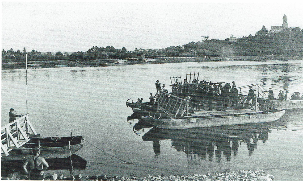
Le bac de 1940 après la destruction du pont de Varades Coll. ARRA.
